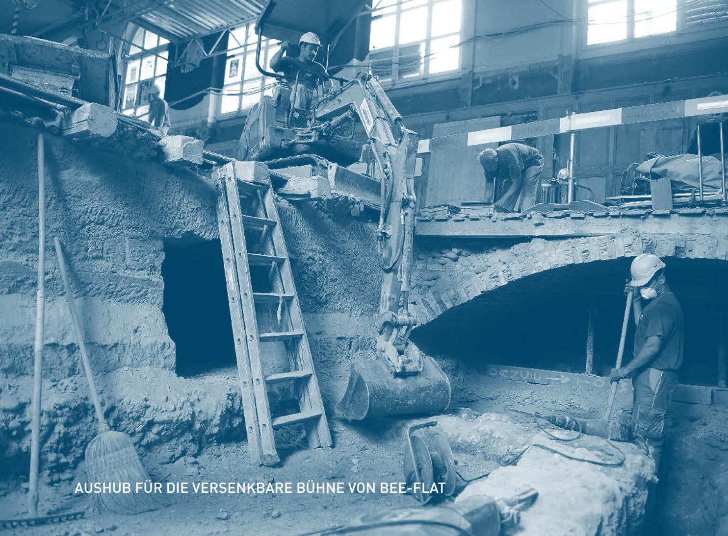
AUSHUB FÜR DIE VERSENKBARE BÜHNE VON BEE-FLAT
